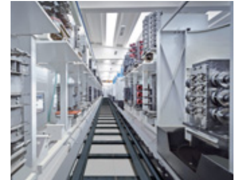
Centro de trabajo horizontal: producción cajas de transmisión y reductores.
